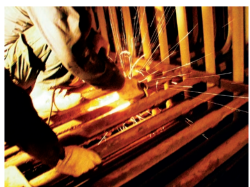
減薄之過熱器管切除作業
