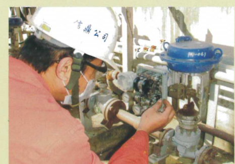
▲柴油儲槽出口氣動閥開度校正調整
