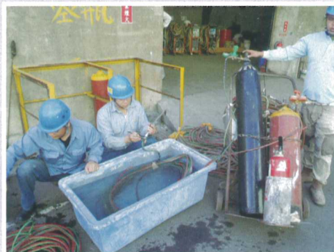
▲機具進廠檢查
