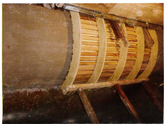
1號爐前牆灌漿
