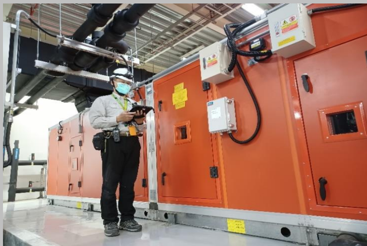
空調箱設備檢修
