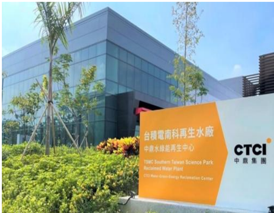
台積電南科再生水廠
