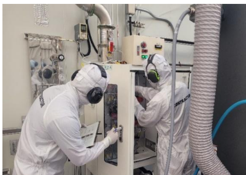
無塵室設備檢修
