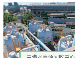
中港水資源回收中心
