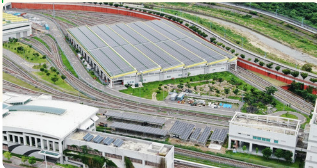
屋頂型 / 中捷北屯機廠 / 5.7 MWp
