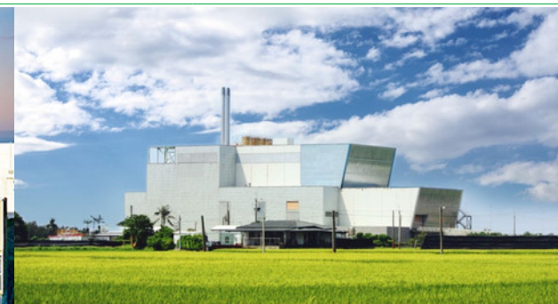
Taitung Energy-Resource Center
