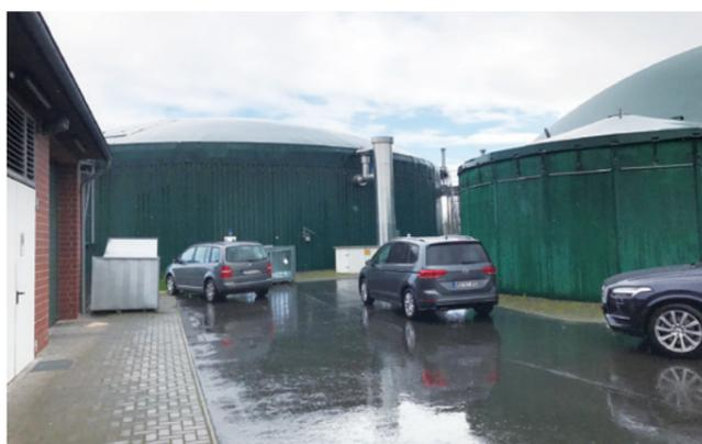
圖2 控制室及廠內發電機房(左)、厭氧消化槽(中)及豬糞尿儲槽(右)(例)
