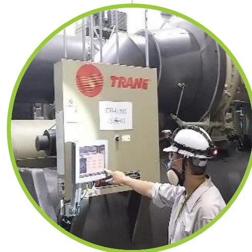
冰水主機設備維護
