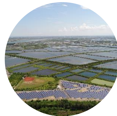
台南城西掩埋場太陽光電廠
