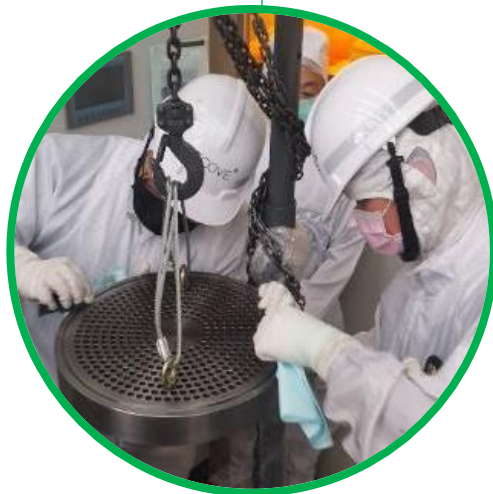
無塵室製程設備檢修
