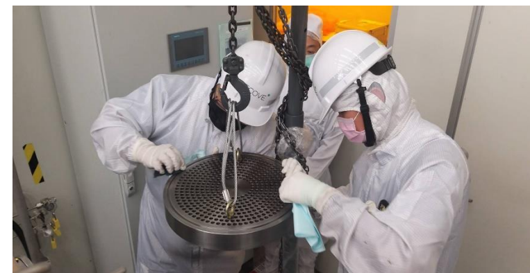
無塵室製程設備檢修
