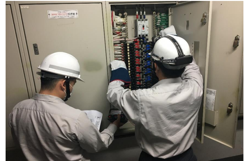
電盤設備檢修
