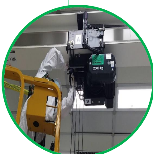
無塵室天車檢修
