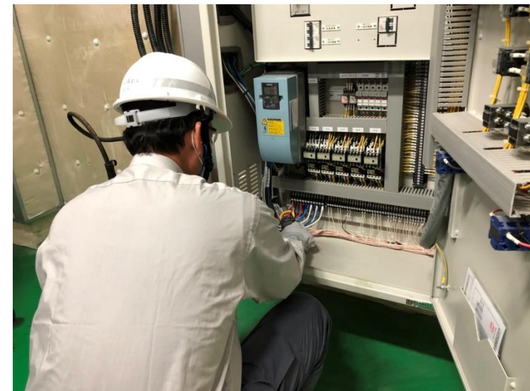
空調箱設備檢修
