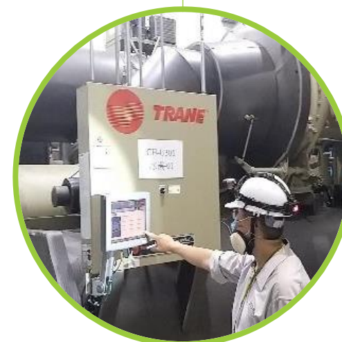
冰水主機設備維護
