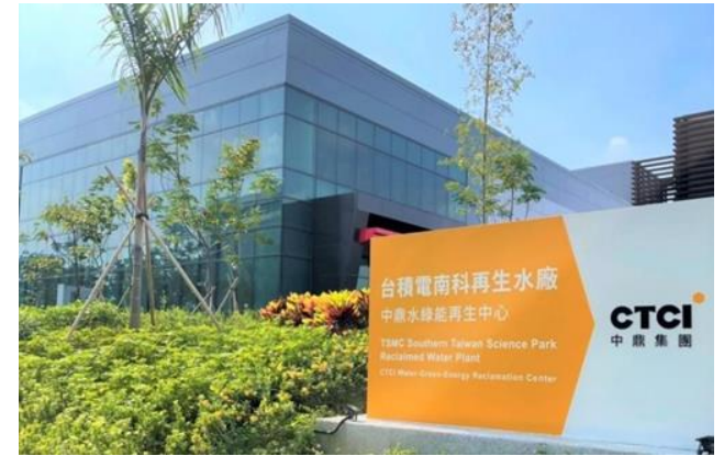
台積電南科再生水廠
