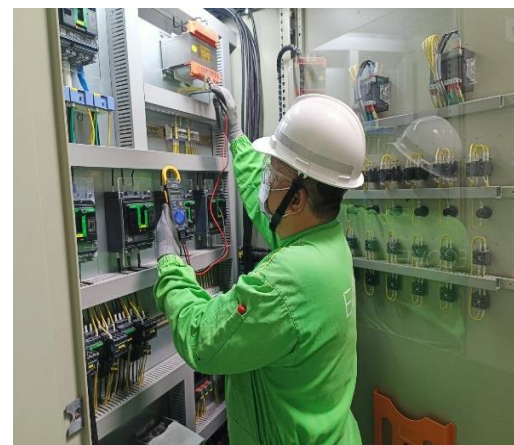
動力分電盤檢修
