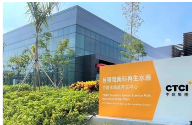
台積電南科再生水廠
