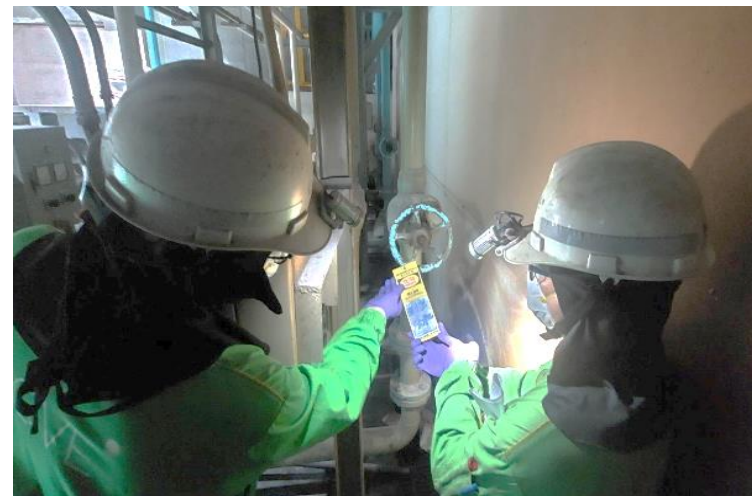
管線設備隔離暨掛牌警示
