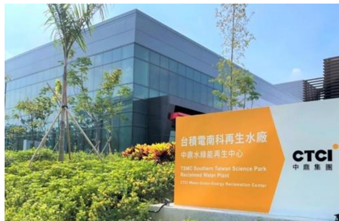
台積電南科再生水廠
