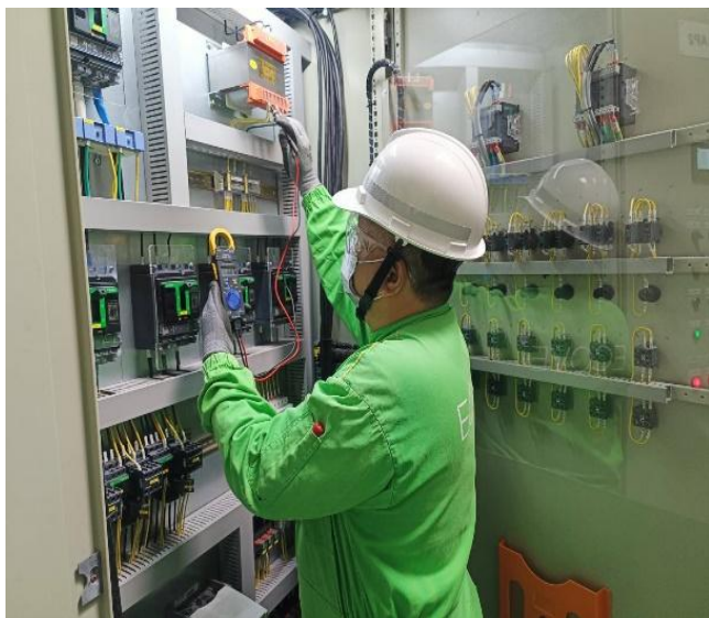
動力分電盤檢修
