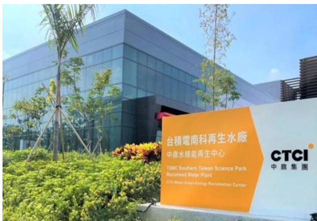
台積電南科再生水廠
