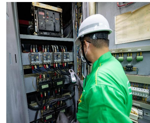
中高壓電氣室檢修
