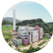
焚化爐與廢棄物處理
