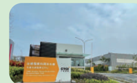
南科台積電再生水廠
