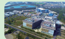
屏東農業生物技術園區水資源處理場
