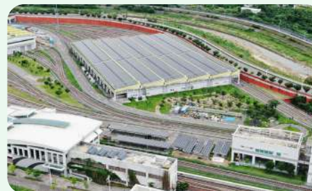
● 屋頂型 / 中捷北屯機廠 / 2.9 MWp
