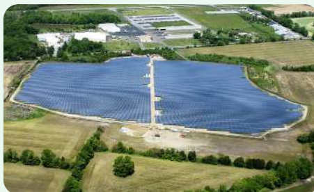
● 地面型 / 美國紐澤西州 Lumberton 太陽能電廠 / 9.5 MWp
