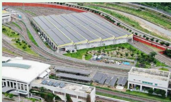
屋頂型 / 中捷北屯機廠 /2.9 MWp
