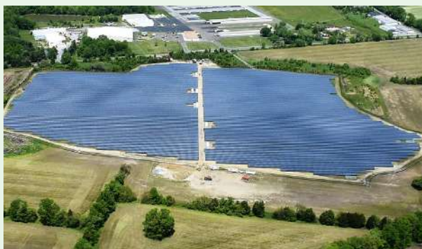
地面型 / 美國紐澤西州 Lumberton 太陽能電廠 /9.5 MWp
