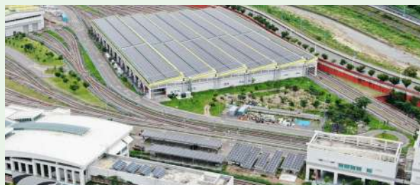
Rooftop type/Taichung Metro Beitun Depot/2.9 MWp
